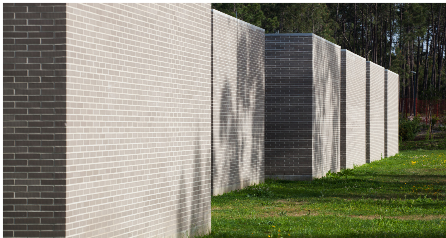
Centro Escolar de Fonte de Angeão | Arq.º Miguel Marcelino Fotografia: José Campos
