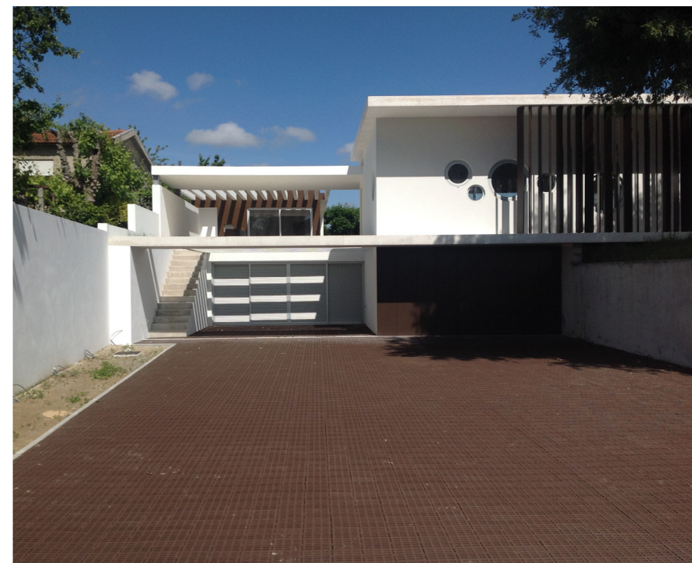
Habitación Unifamiliar | Arq.ª Bárbara Abreu
